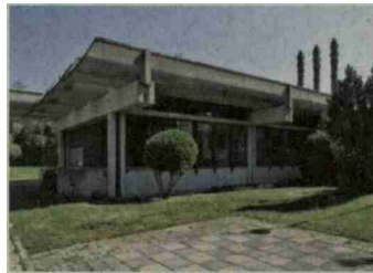
Auf dem Areal von Agrico soll ein Contracting entstehen. Bild ae/a
